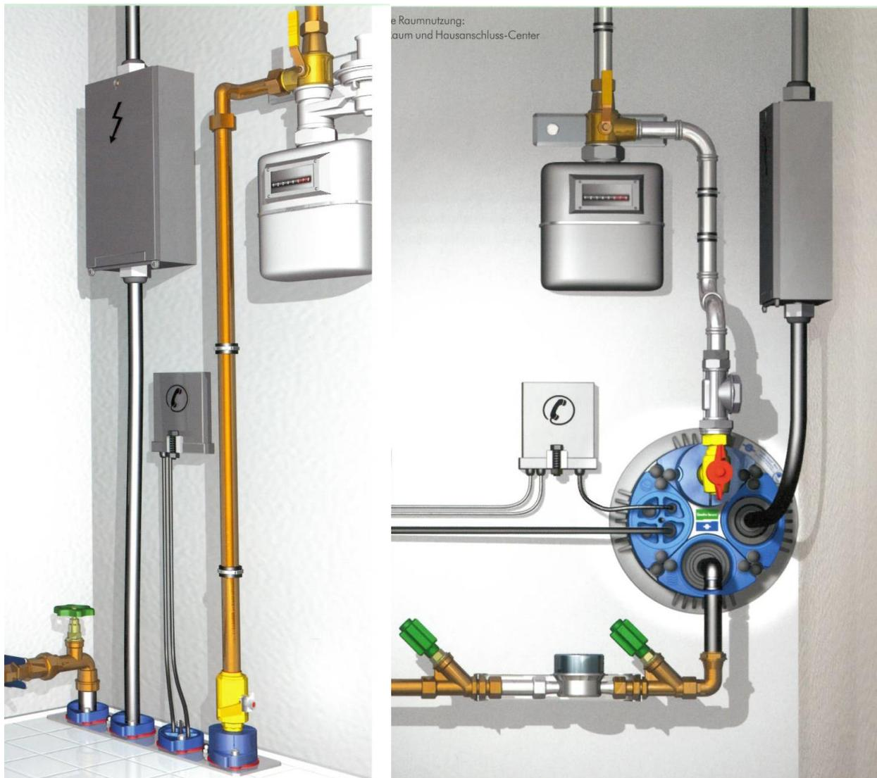
Abbildung 2: Beispiel Mehrspartenhauseinführung ohne Keller (Bodenplatte) und im Keller
